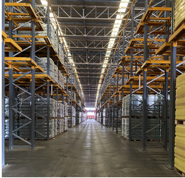
Figure 1.1: Almacenamiento en estanterías elevadas.
