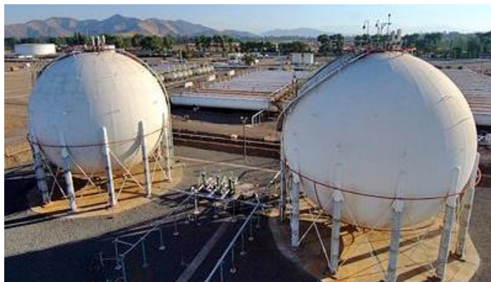
Fig. 2.4. Tanque esférico en planta Enap Maipú.
