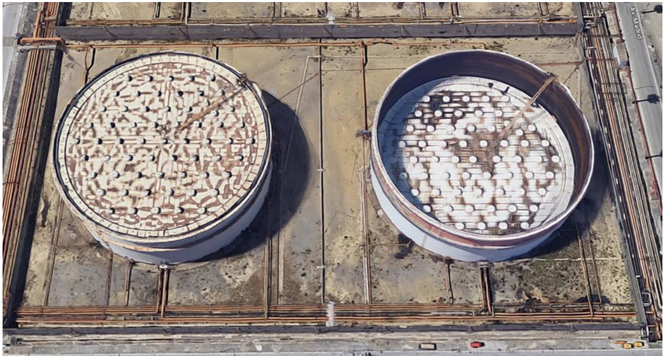
Fig. 3.32 Techos flotantes. Fuente Prefire.es
