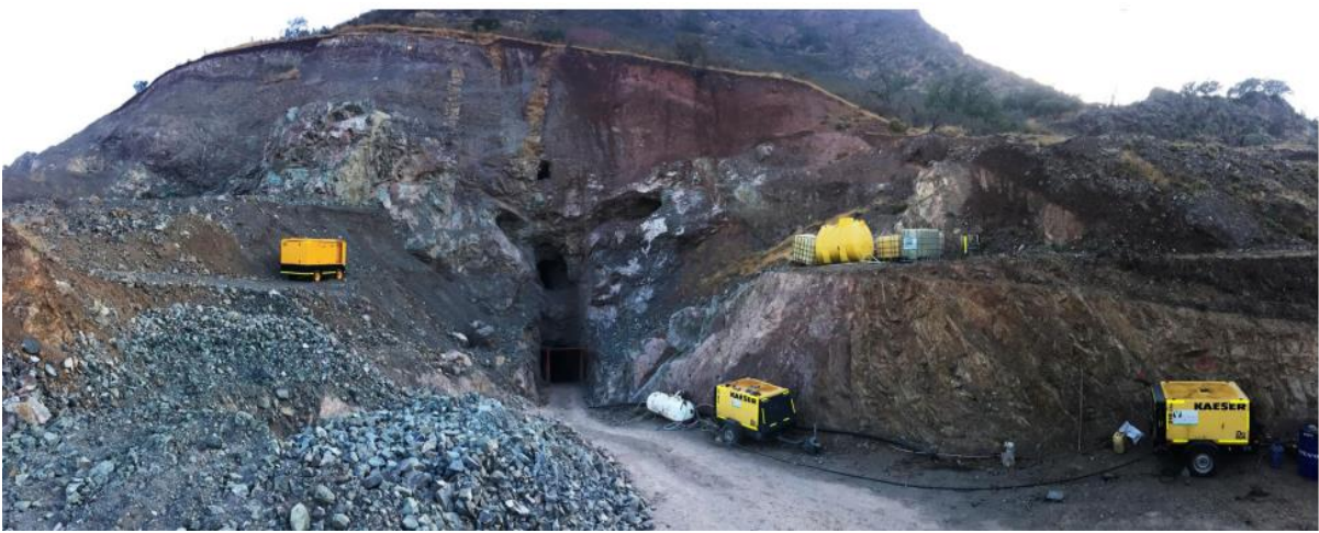
Ilustración 1: Nivel 1, entrada mina la verdosa.
