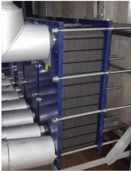
Figura 2-7: Intercambiador de calor de placas.
