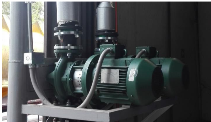
Figura 2-9: Bombas centrífugas.
