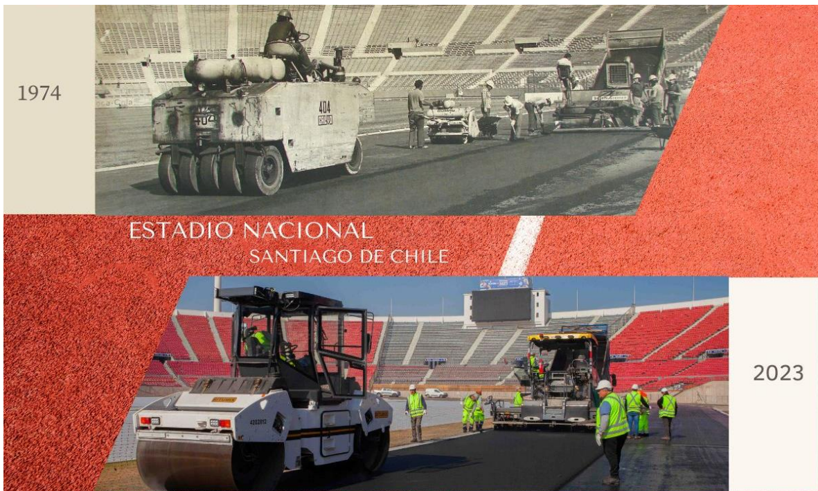
Figura 2-1. Conmemoración 50 años. Obras de pavimentación en estadio nacional.
