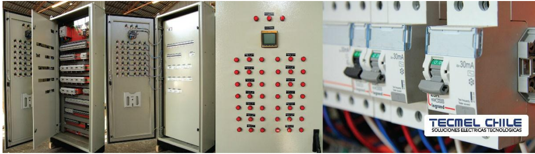
Ilustración 12: Tablero de protecciones y control. Fuente: www.tecmelchile.cl
