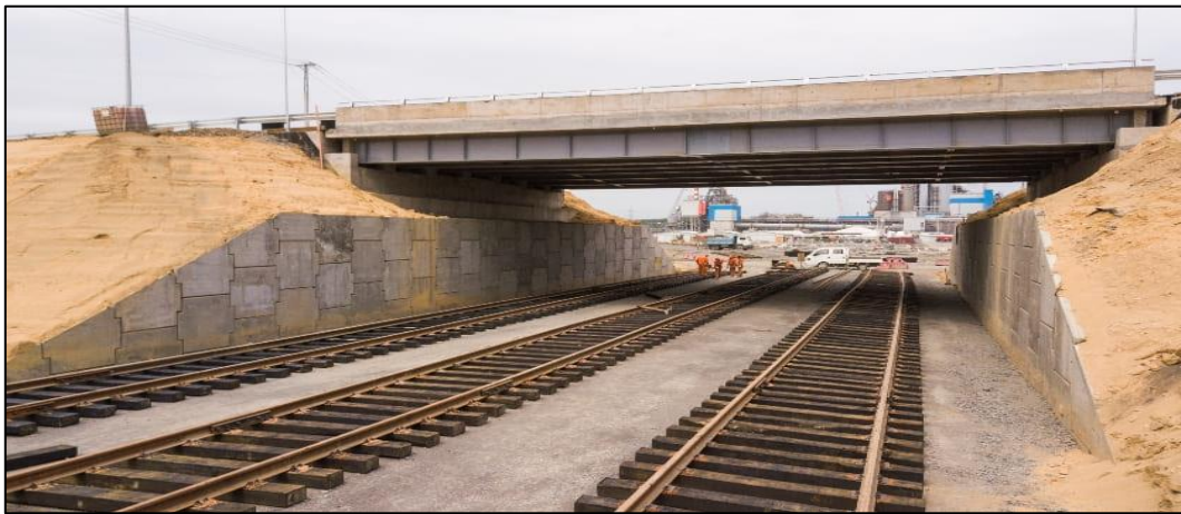
Figura 18: Ejemplificación de Muro TEM, proyecto Arauco.
