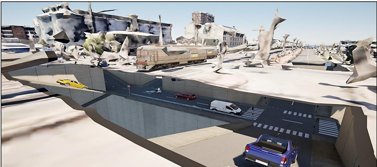
Figura 25: Foto Montaje de Soterramiento Cruce Ferroviario Desiderio Sanhueza.
