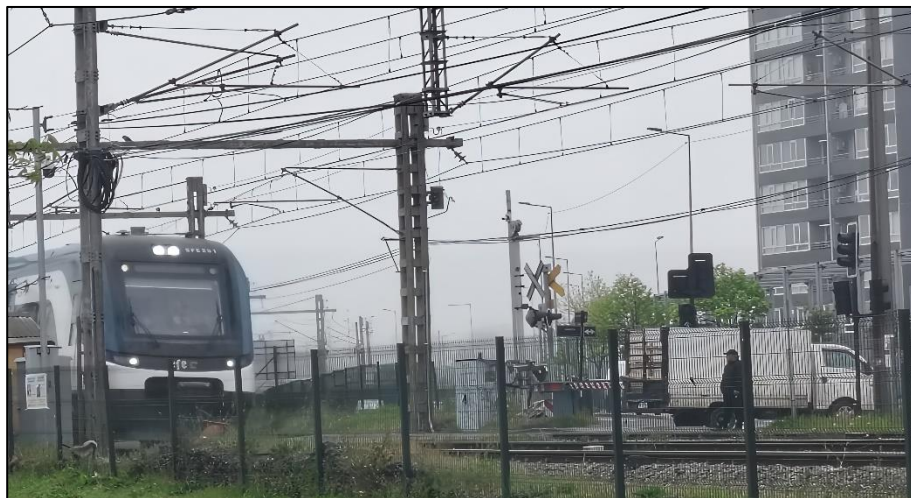
Figura 11: Inseguridad Vial el vehículo se encuentra ubicado entre la faja vía con las barreras abajo.
