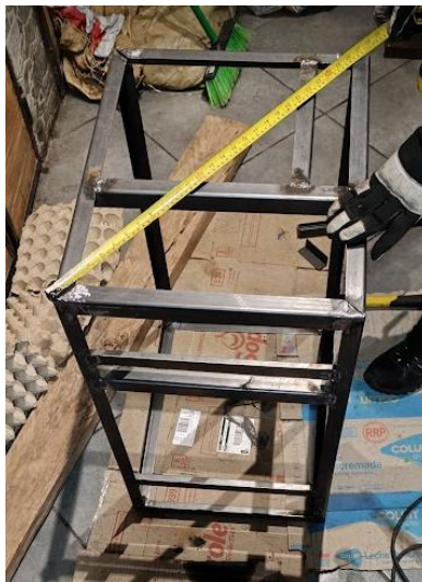
Figura 44. Estructura del banco ya completada, realizando revisión de diagonales.
