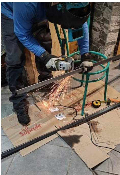
Figura 41. Corte de perfil metálico utilizando una esmeriladora angular
