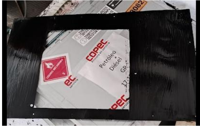
Figura 49. Realización del proceso de aplicación de pintura Anticorrosiva en las planchas
