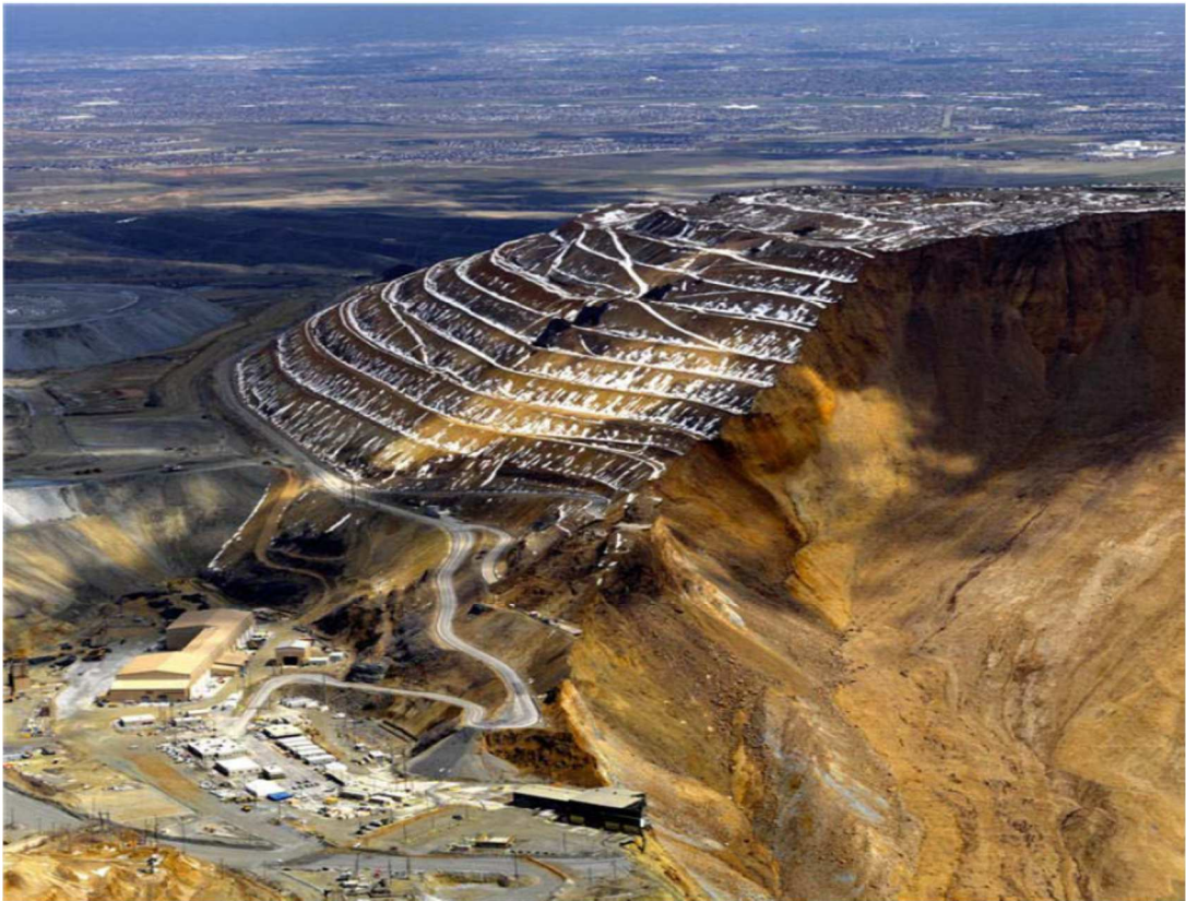
Ilustración 3.4-3 Deslizamiento (Slide) En Bigham CANYON 13-04-2013
