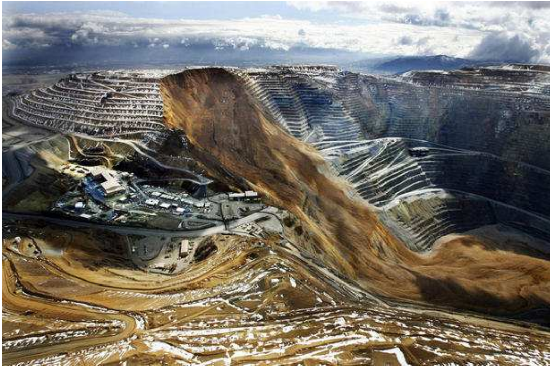
Ilustración 3.4-2 Deslizamiento (Slide) En Bigham Canyon 13-04-2013
