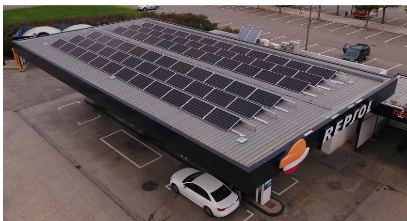
Figura 18: Utilización ERNC en estaciones de combustible.
