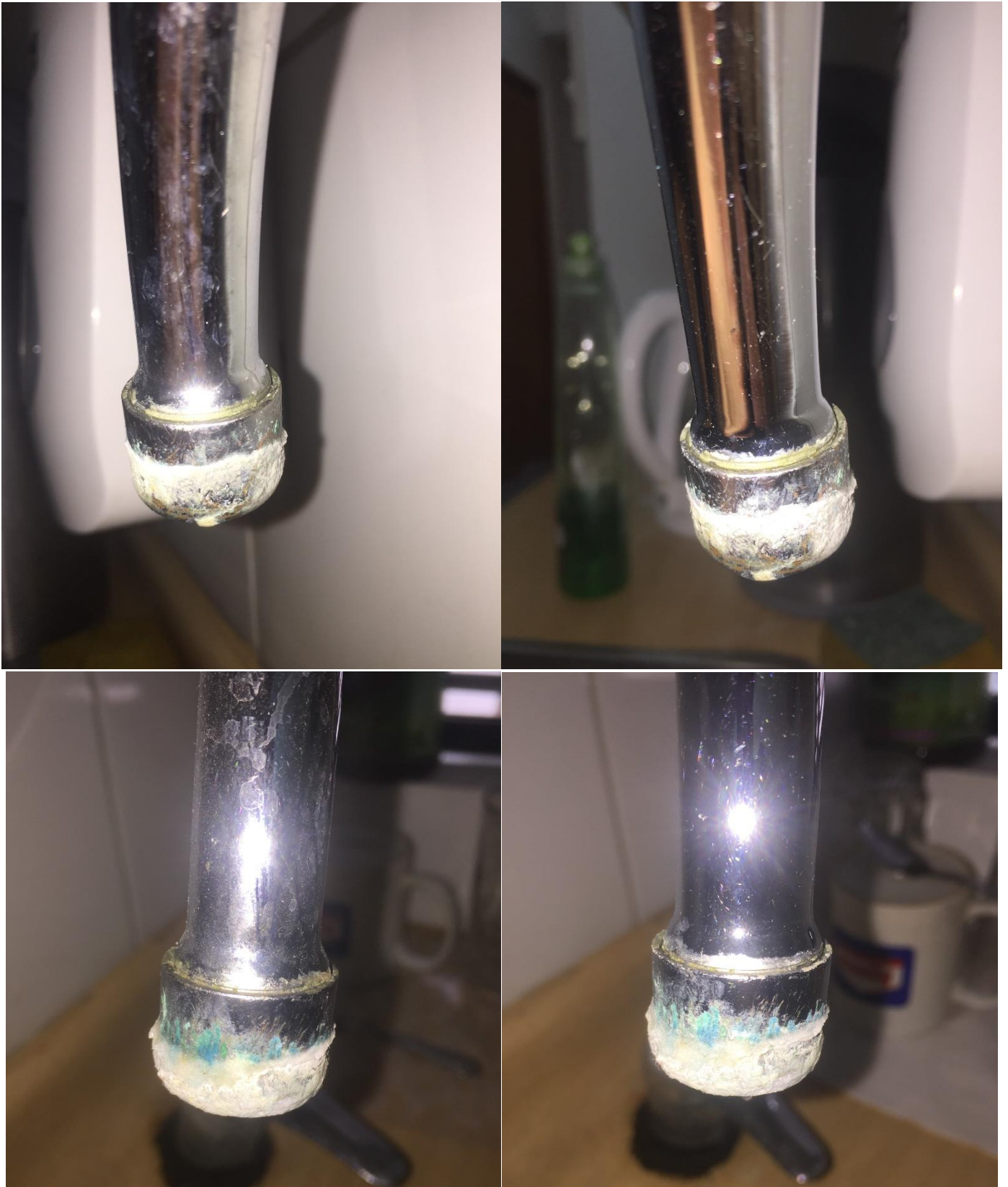
Imagen 24: Comparación antes (izquierda) y después (derecha) de la limpieza, en el ducto de salida de la grifería, del sector para café de las oficinas.
