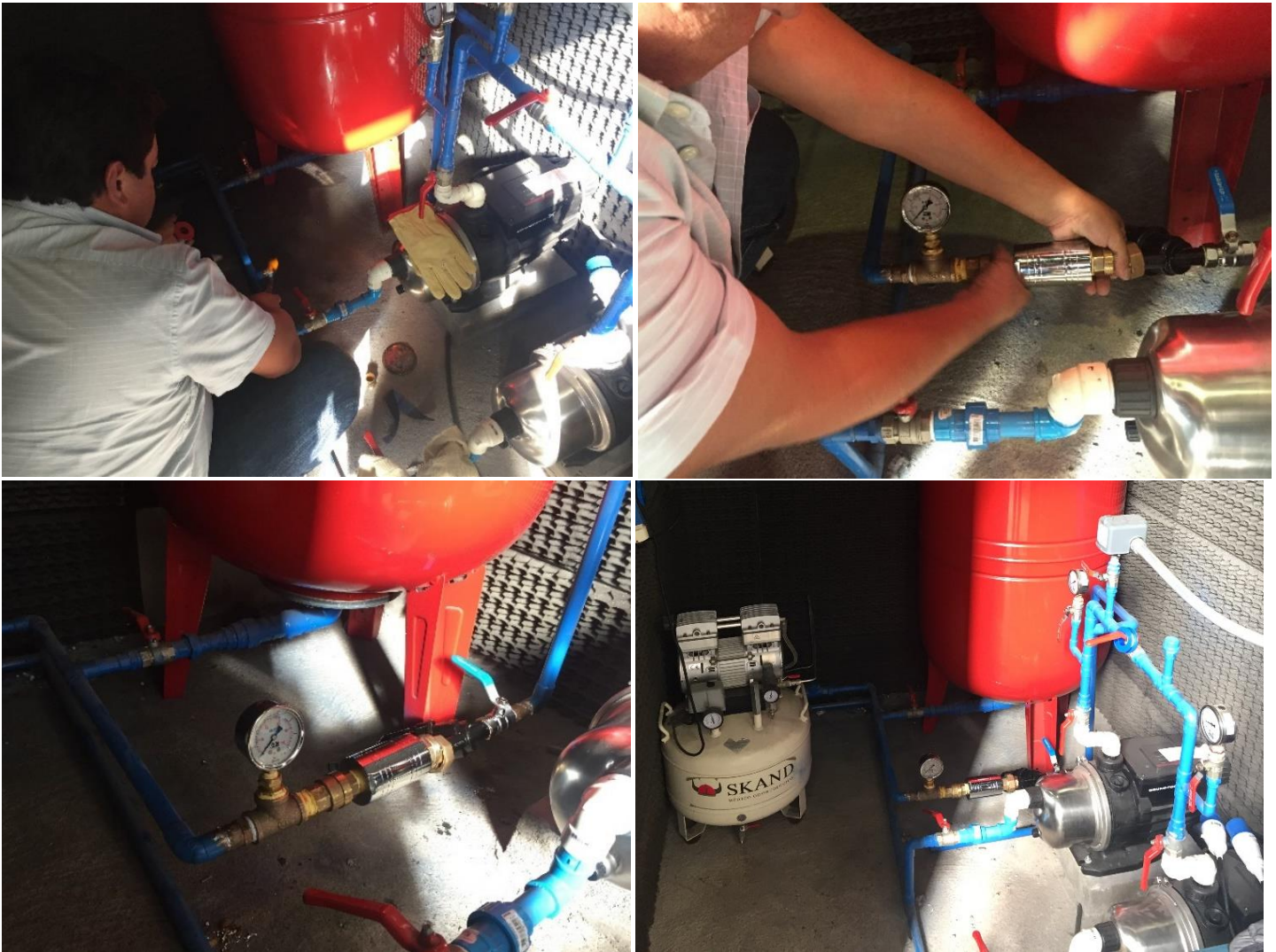
Imagen 1: Instalación del Acelerador iónico el día 07/08/18.
