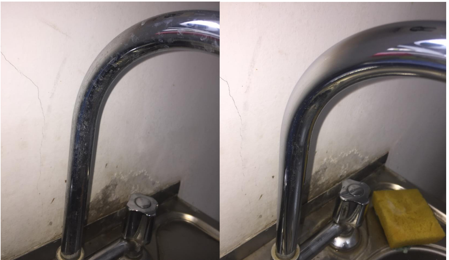
Imagen 21: Comparación antes (izquierda) y después (derecha) de la limpieza, en la tubería de salida de la grifería, del sector comedor del laboratorio.
