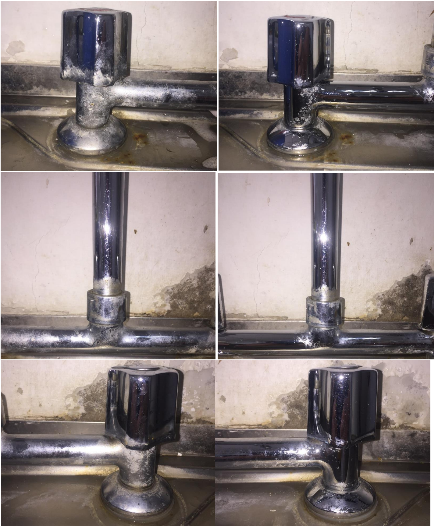
Imagen 22: Comparación antes (izquierda) y después (derecha) de la limpieza, en el detalle de las llaves de la grifería, del sector comedor del laboratorio.
