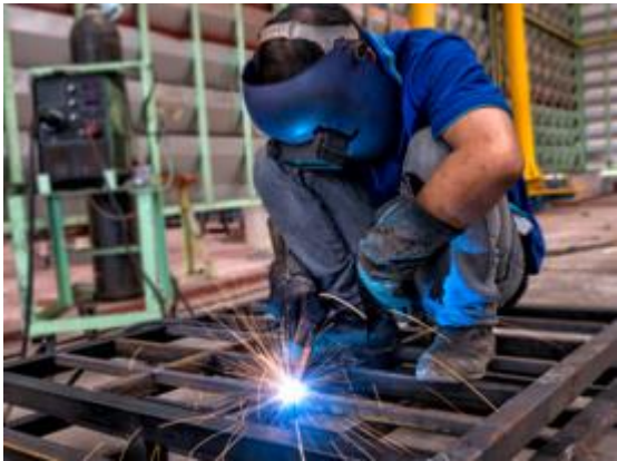
Figura 1-34. Estructura metálica Fuente archivo Google (2021)
