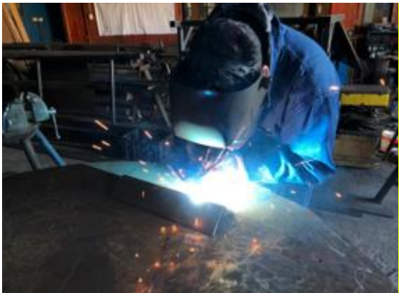
Figura 2-2. Soldadura de acero
