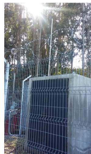
Imagen 3.5 Cerco perimetral y caseta de Canal Unidos
