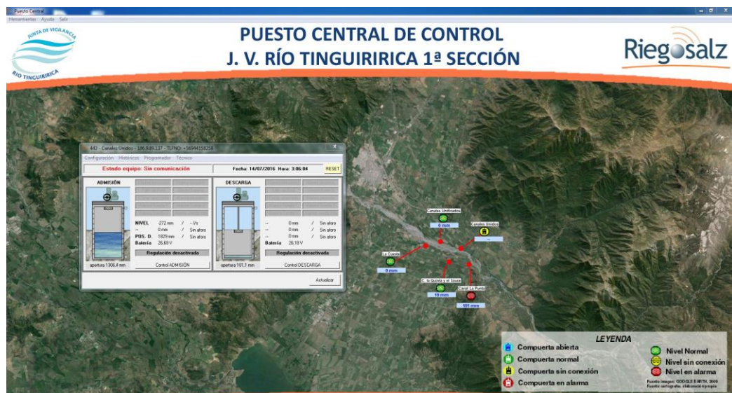
Imagen 4.5 Vista del cliente del nivel de compuerta
