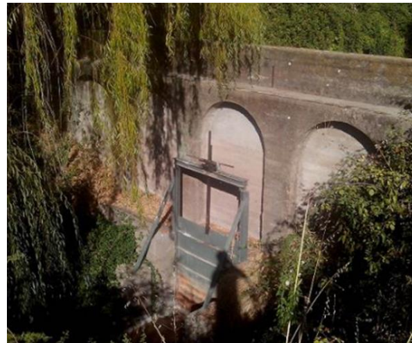
Imagen 3.3 Muro vertical y compuerta de hoja. Canal El Manzano.
