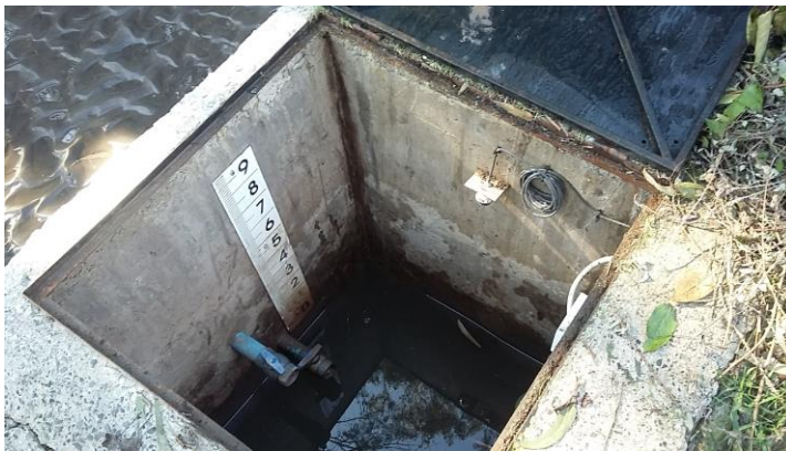
Imagen 3.11 Pozo de estabilización de hormigón armado de Canal Unidos
