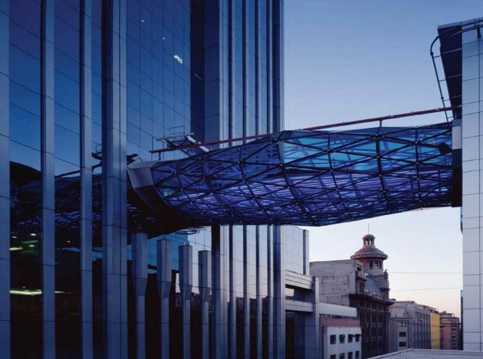
Puente Banco Santander, Santiago, Chile 2003
