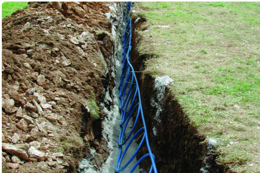
Figura 4-5. Ramal de circuito horizontal con tipología “Slinky vertical”.
