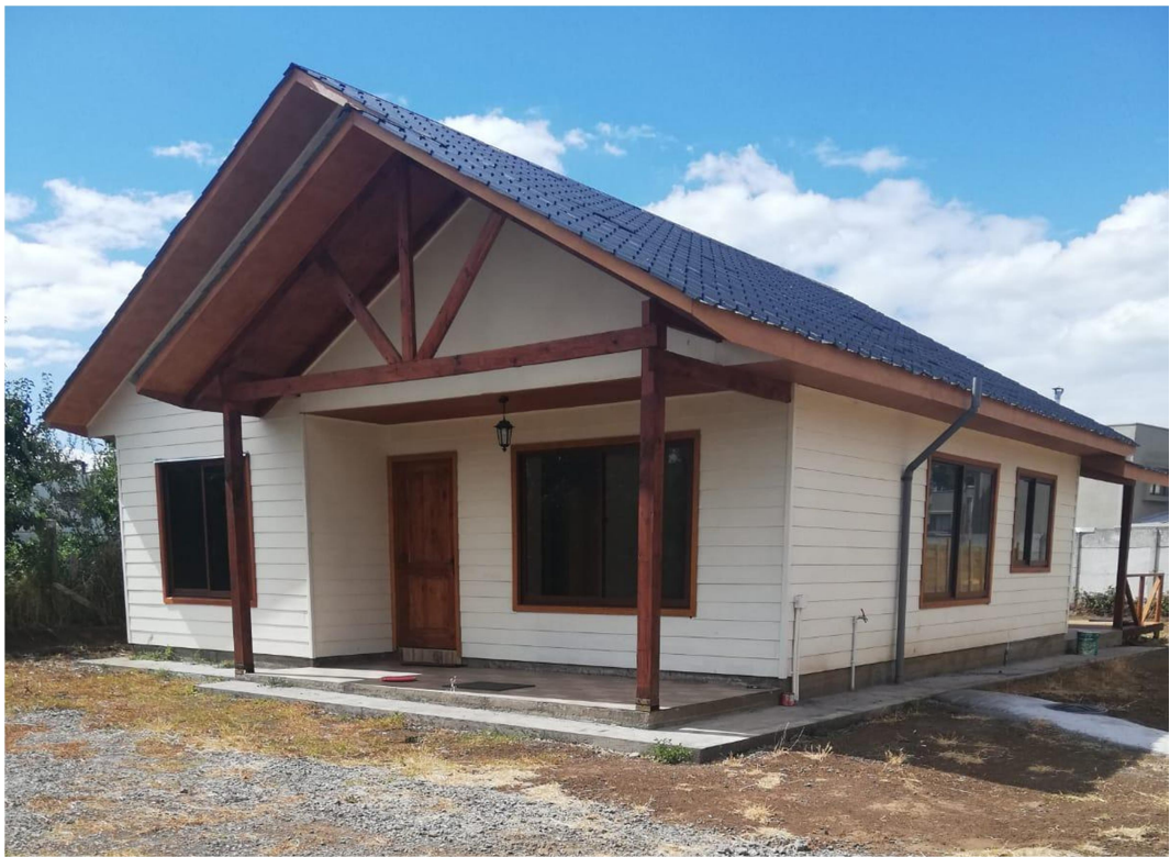
Figura 3-3. Imagen de la vivienda. Fuente: Elaboración propia.
