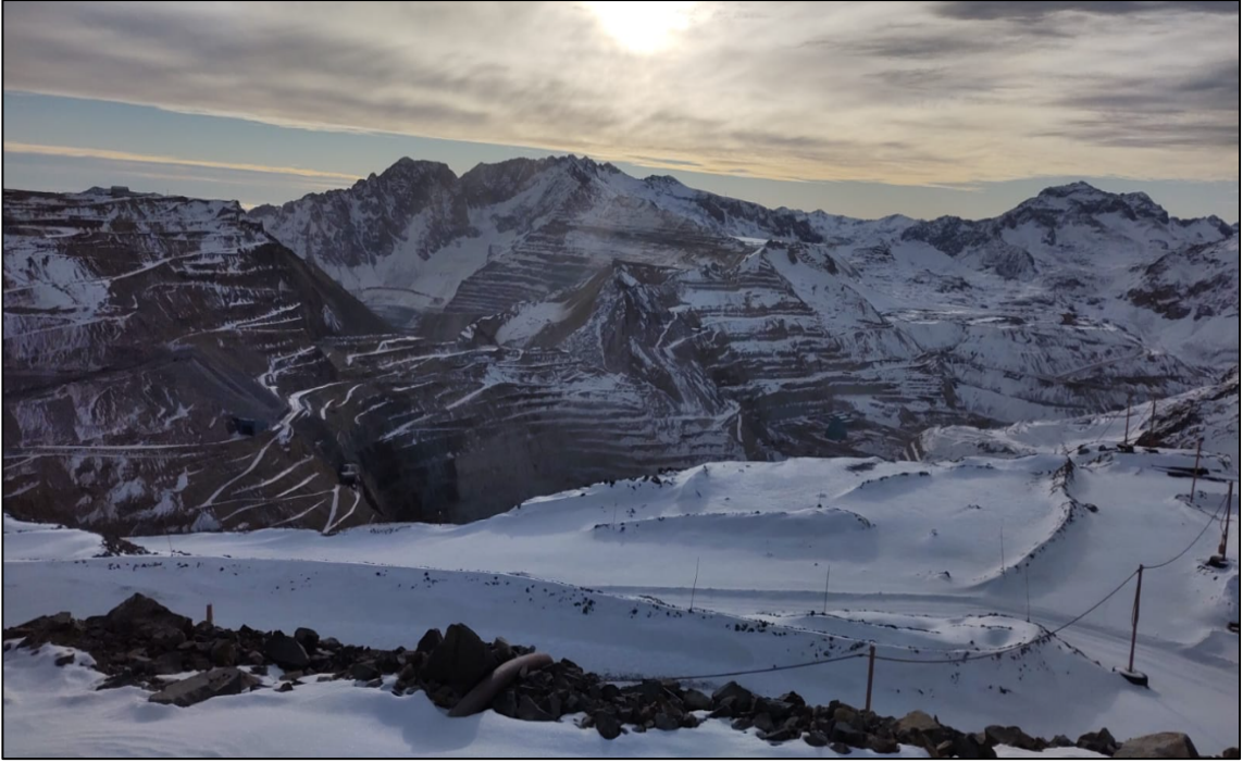
Figura 3: Vista Mina Sur Sur.
