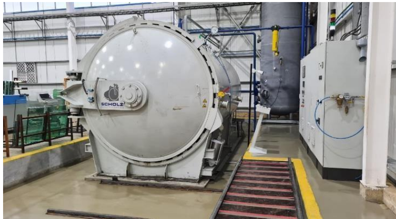
Figura 3-15: Zona de Autoclave.
