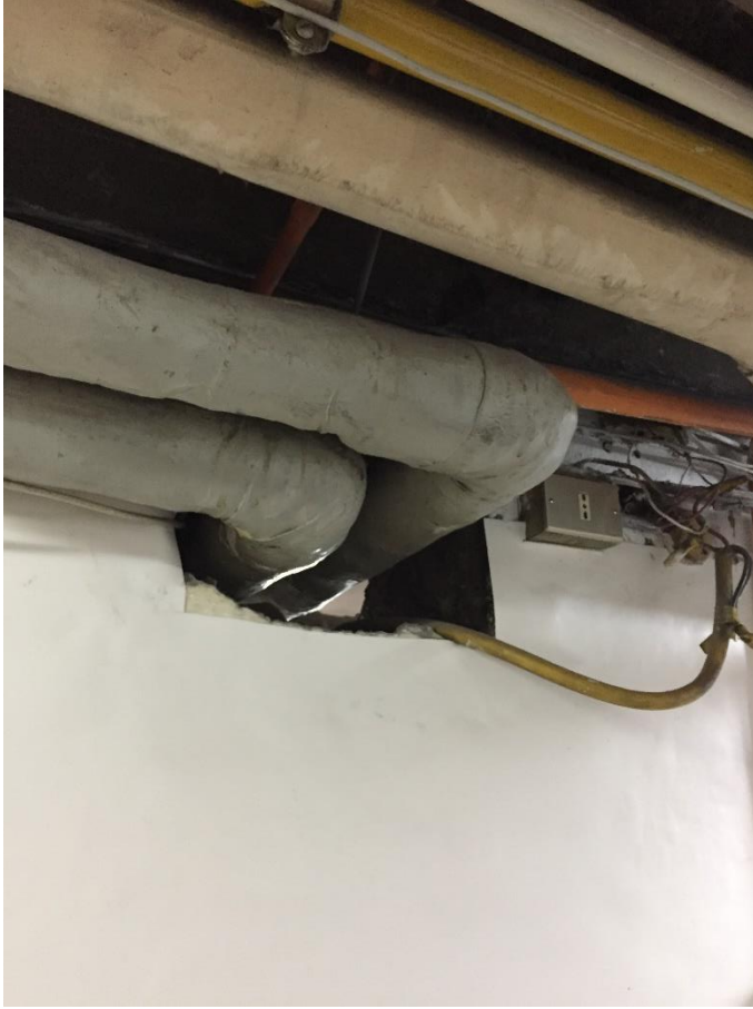
Ilustración 3-43: Penetración de muros
