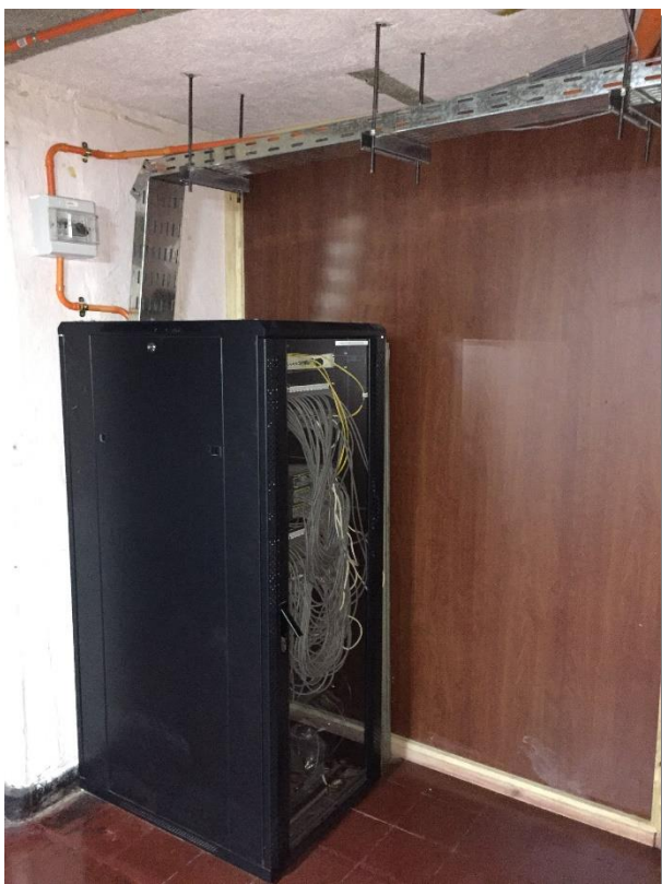
Ilustración 3-21: Instalación línea de datos
