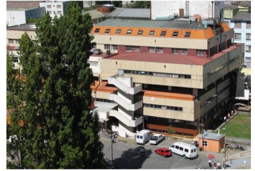
Ilustración 2-4: 1987 Torre Servicios de Urgencia
