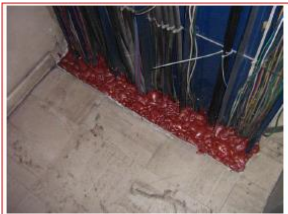
Ilustración 3-29: Instalación CP 620
