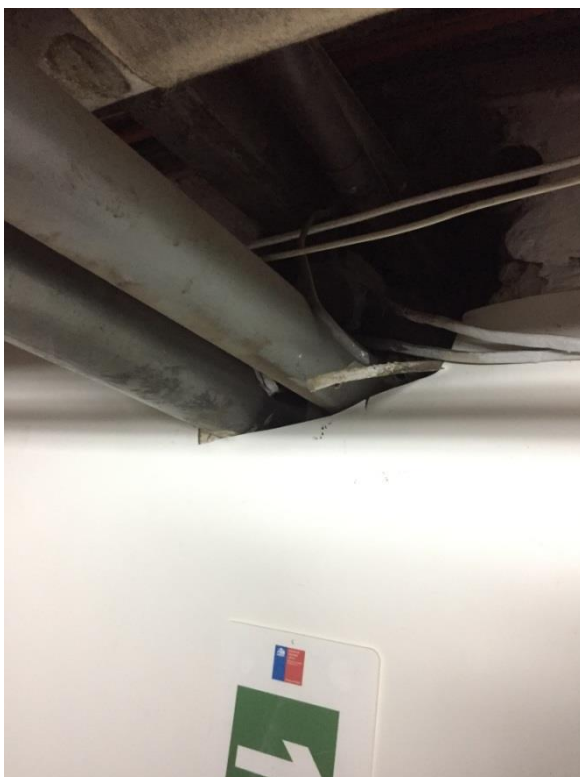
Ilustración 2-7: Penetraciones de cañerías
