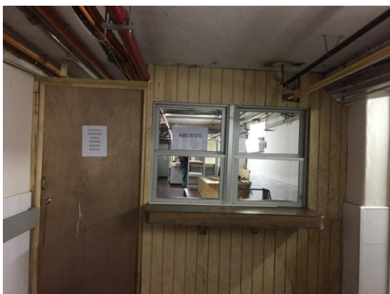
Ilustración 3-5: Ingreso Sector Archivos Clínicos
