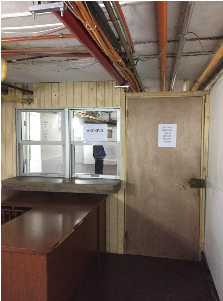
Ilustración 3-22: Tabique de madera
