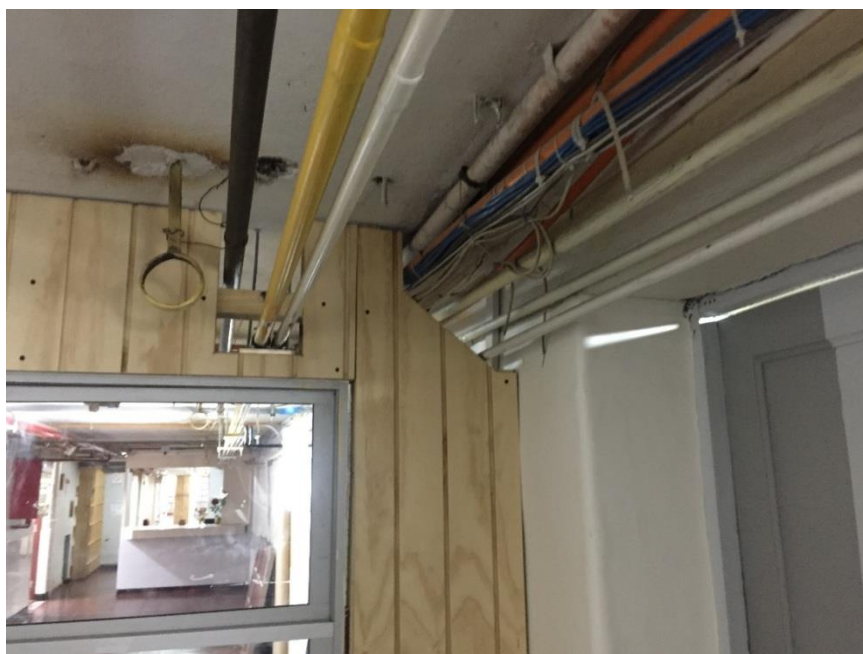
Ilustración 3-42: Aplicación collarín en penetración de cañerías
