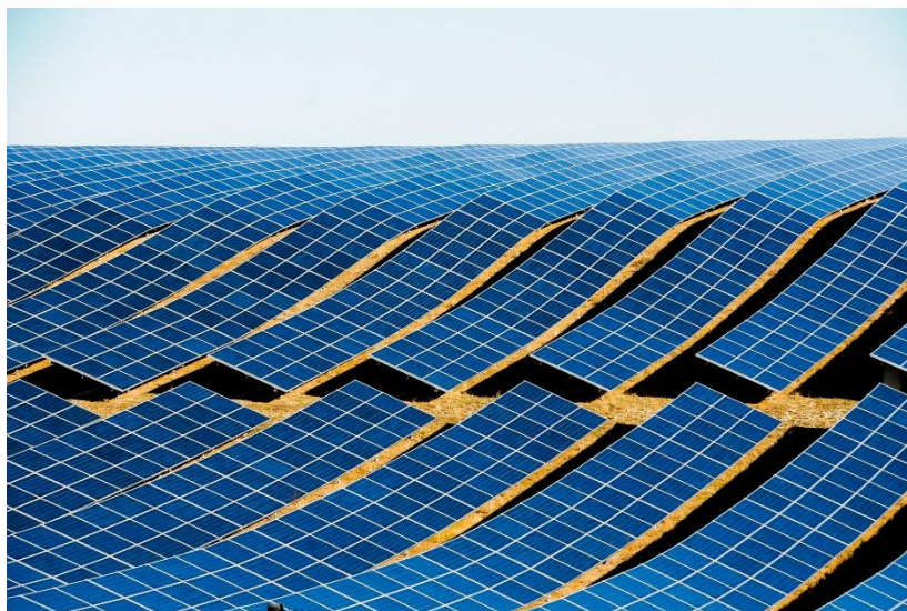
Figura 17: Paneles solares de tipo thin film. Extraída de [38].
