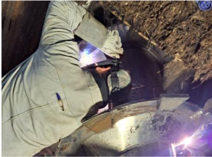
Figura 3-3: Proceso de soldadura en terreno.
