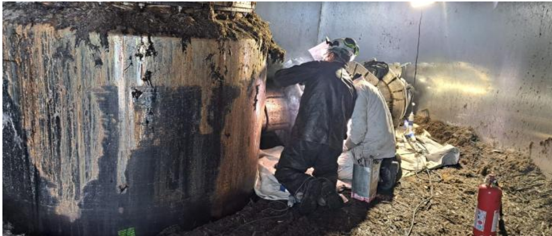
Figura 3-4: Montaje de rompedores al interior de silo.
