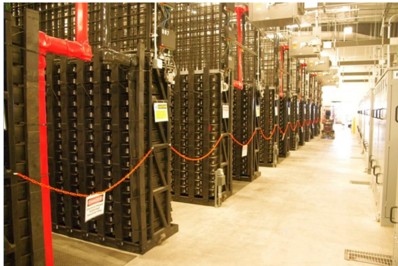
Figura 7: Baterías (izq.) y Sistema de Conversión de Potencia (der.)
