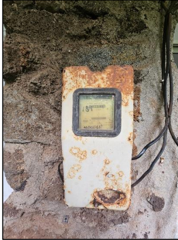
Figura 1-6 Estado actual del equipo de medida y del alimentador.
