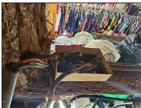
Figura 1-9 Condición deficiente de conductores y canalizaciones.
