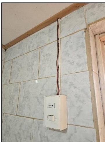
Fuente: Elaboración propia. Figura 1-8 Artefacto interruptor enchufe.
