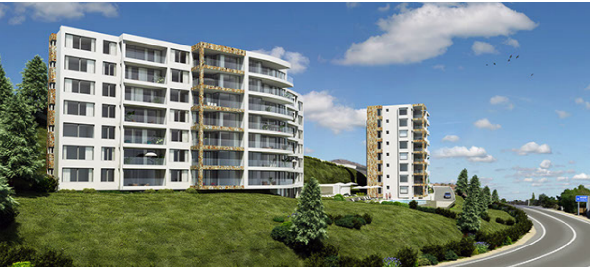
2.1. Proyecto Habitacional - Condominio Punta Pite, Concón Fuente: FV Arquitectos
