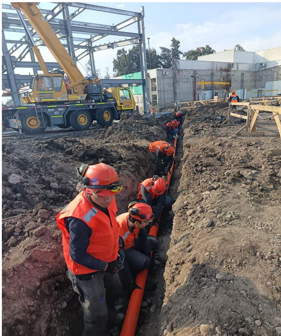
Figura 6: Canalización subterránea.
