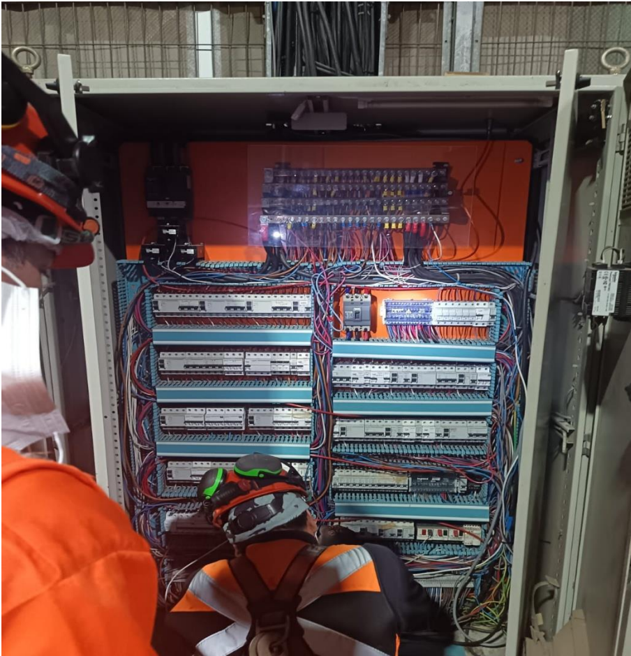
Figura 8: Mantenimiento de tablero eléctrico.
