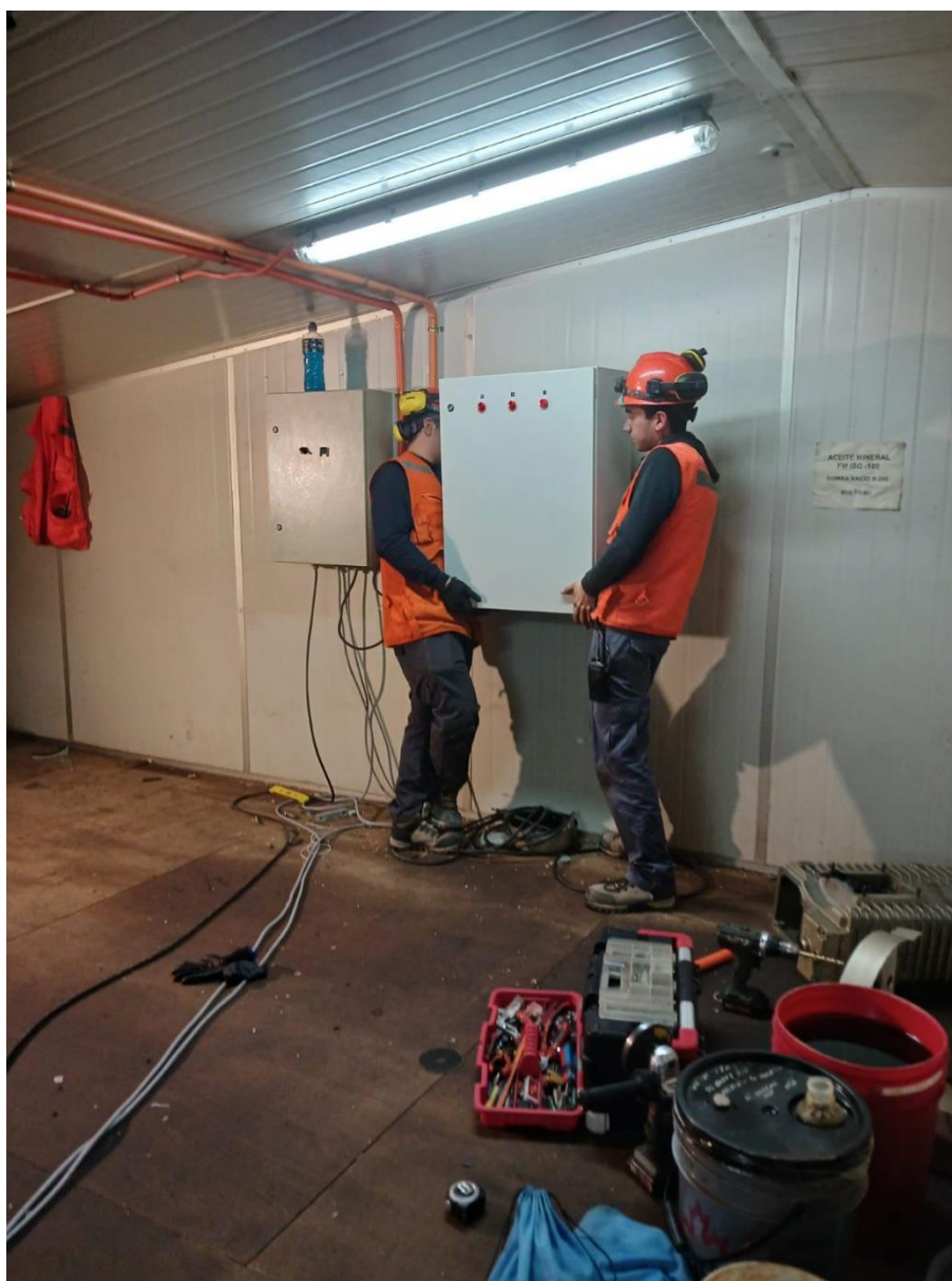
Figura 1: Montaje de tablero eléctrico.
