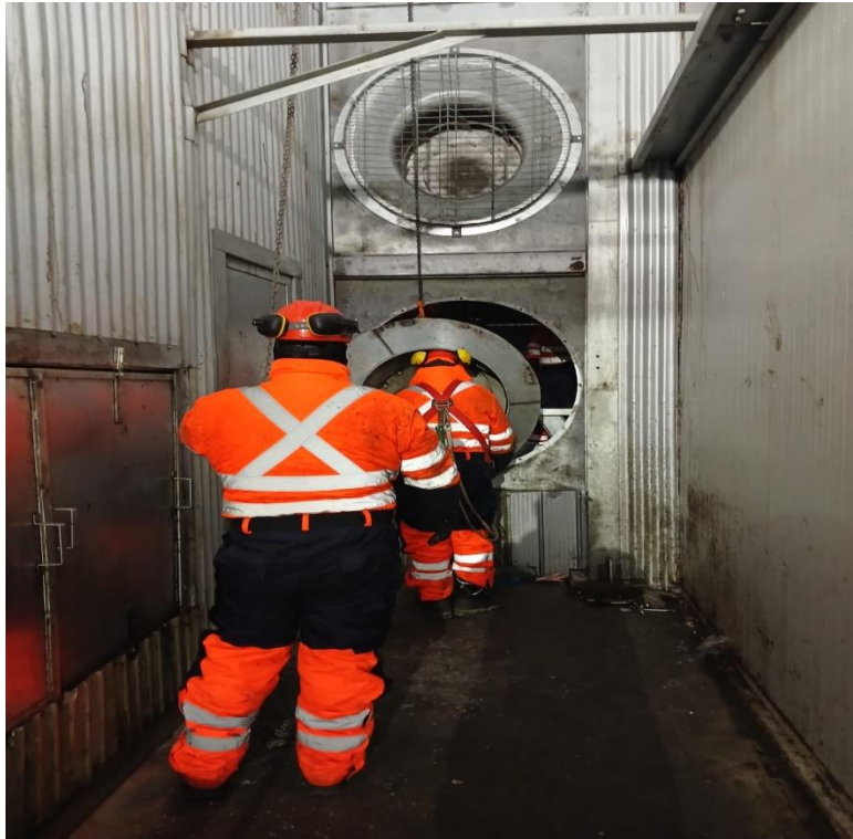
Figura 4: Montaje y desmontaje de motores.
