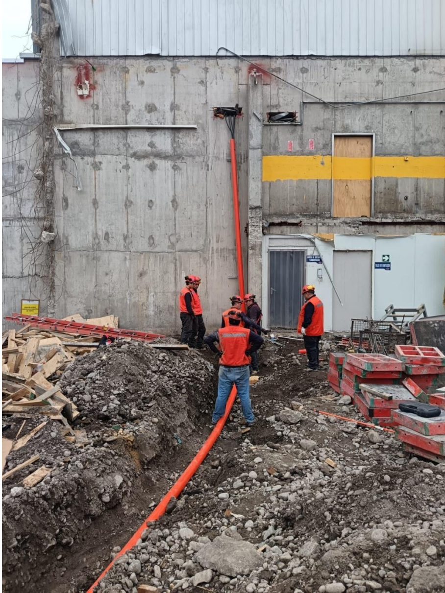
Figura 7: Canalización subterránea.
