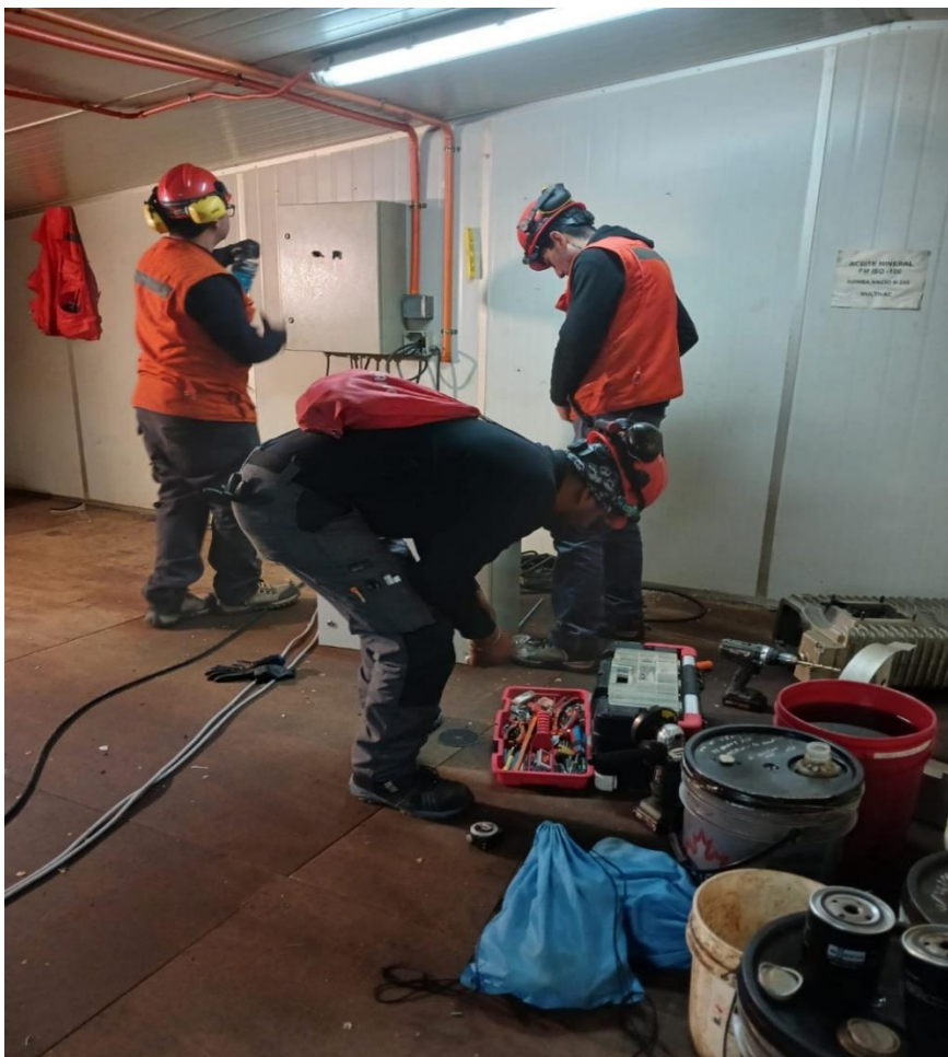
Figura 2: Montaje de tablero eléctrico.
