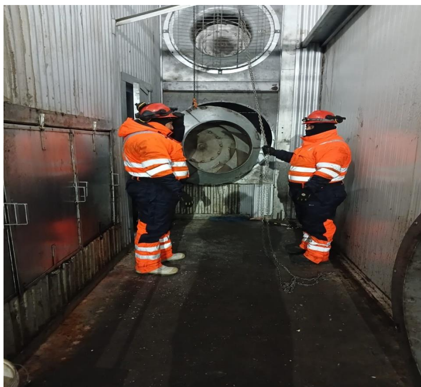
Figura 3: Montaje y desmontaje de motores.
