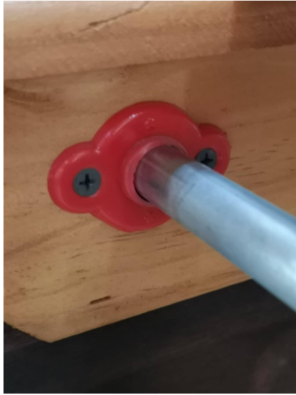
(a) Buje plástico normalmente utilizado en taca-taca con barras telescópicas.
