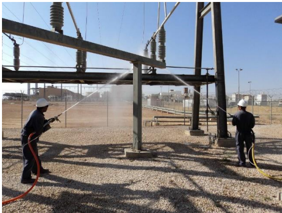
Figura 7. Limpieza de aisladores. (Fuente: Highlinedivision,2021)
