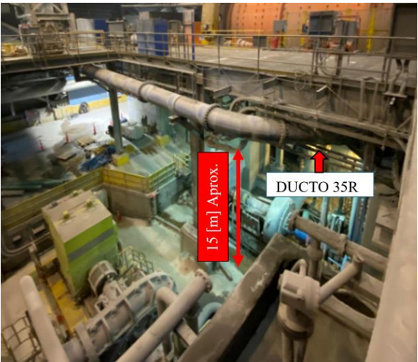
Figura 3-2. Imagen del área, distancia piso a ducto 35R
