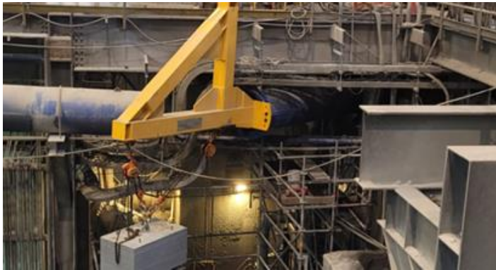
Figura 2-28. Culminación montaje ducto de repuesto 35R
