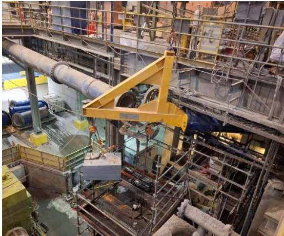
Figura 2-27. Montaje ducto de repuesto 35R
