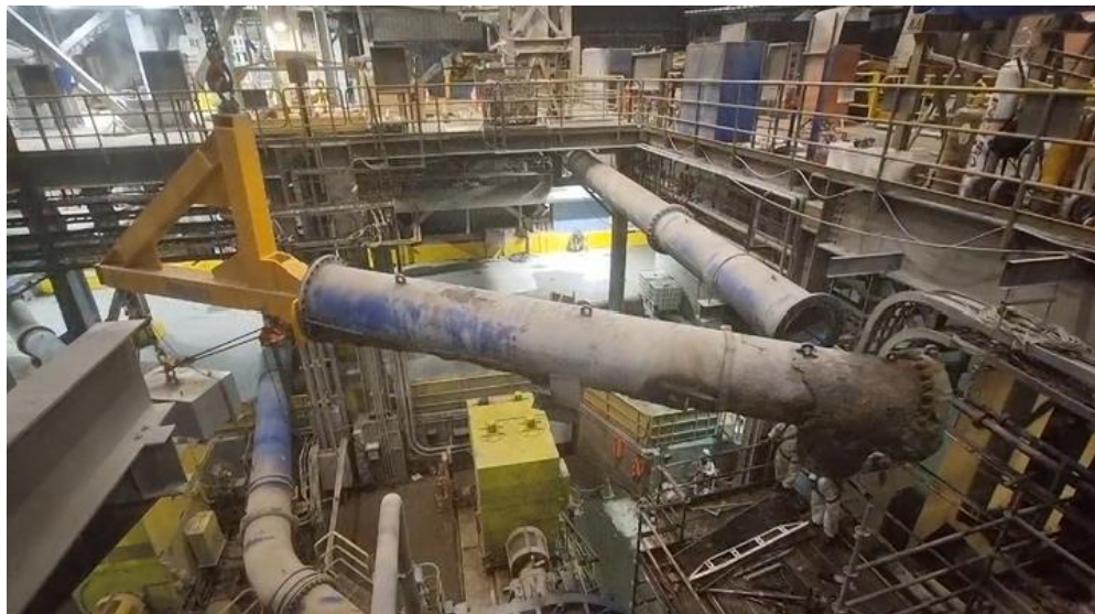
Figura 2-26. Desmontaje ducto 35R
