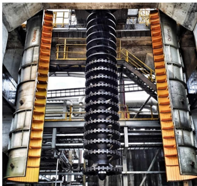
Figura 2-4: Vista general del interior del cuerpo del molino
