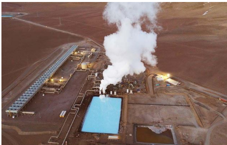
Figura 1.9: Central Geotérmica Cerro Pabellón, Chile (La Tercera, 2019).
