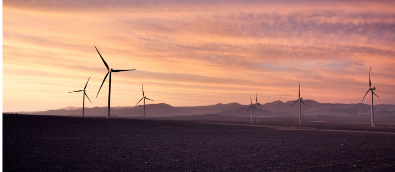
Figura 1.10: Parque Eólico Sierra Gorda, Chile (Enel Green Power, 2022b).
