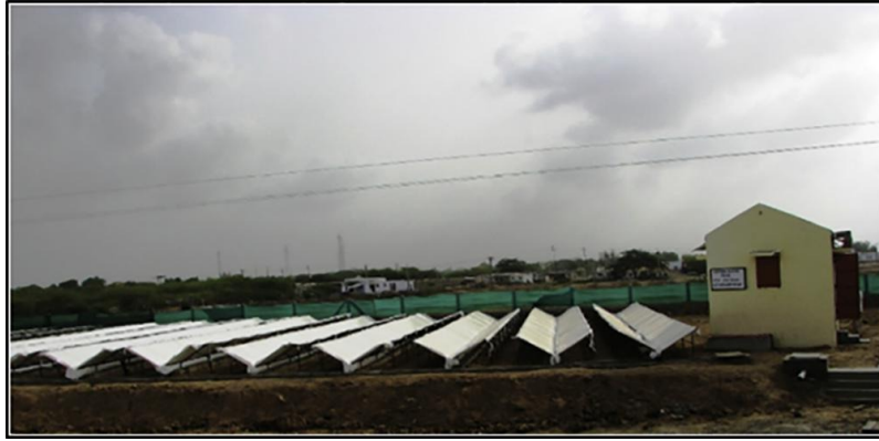
Figura 3.23: Planta de recolección de rocío instalada en una aldea en Gujarat, India (G. Raveesh, R. Goyal, S.K. Tyagi, 2021).
