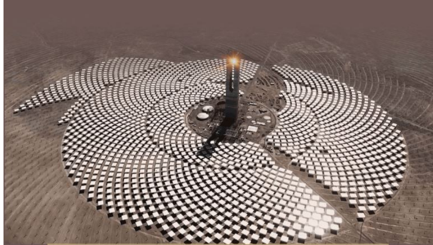
Figura 1.8: Complejo solar Cerro Dominador, Chile (Juan Pablo Bravo, 2018).
