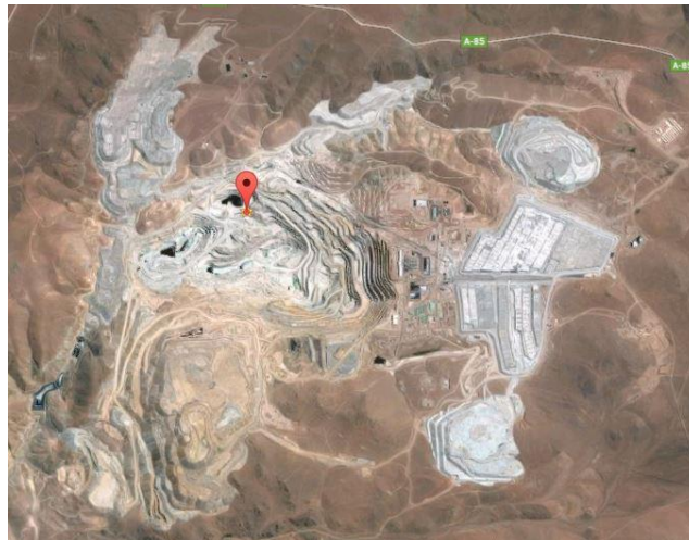
Figura 4: Vista satelital Mina Quebrada Blanca.
