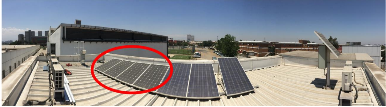
Figura 37 Plantas solares disponibles en techo edificio mecánica campus San Joaquín
