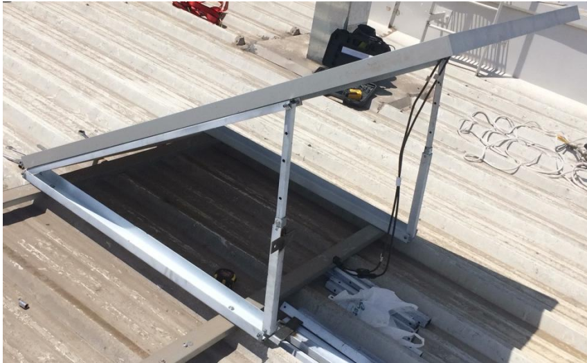
Figura 39: Soporte de panel con brazo telescópico y ángulo variable
