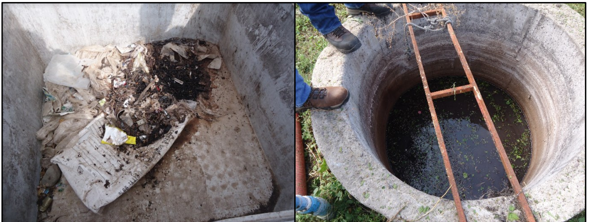
Figura 14: Fotografía - Pozos de recepción para filtrado.
