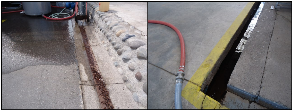
Figura 8: Fotografía - canales RIL zonas adyacentes.
