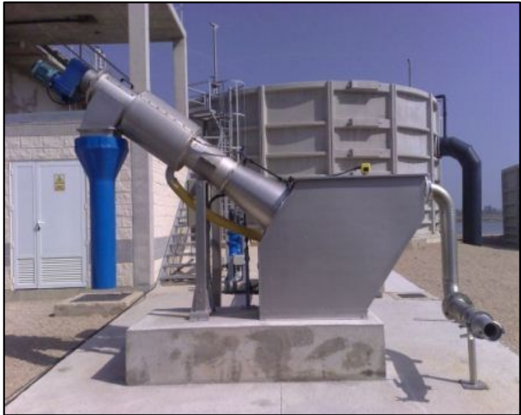
Figura 31: Tamiz tornillo con caja de recepción. (NUTECO, 2019)
