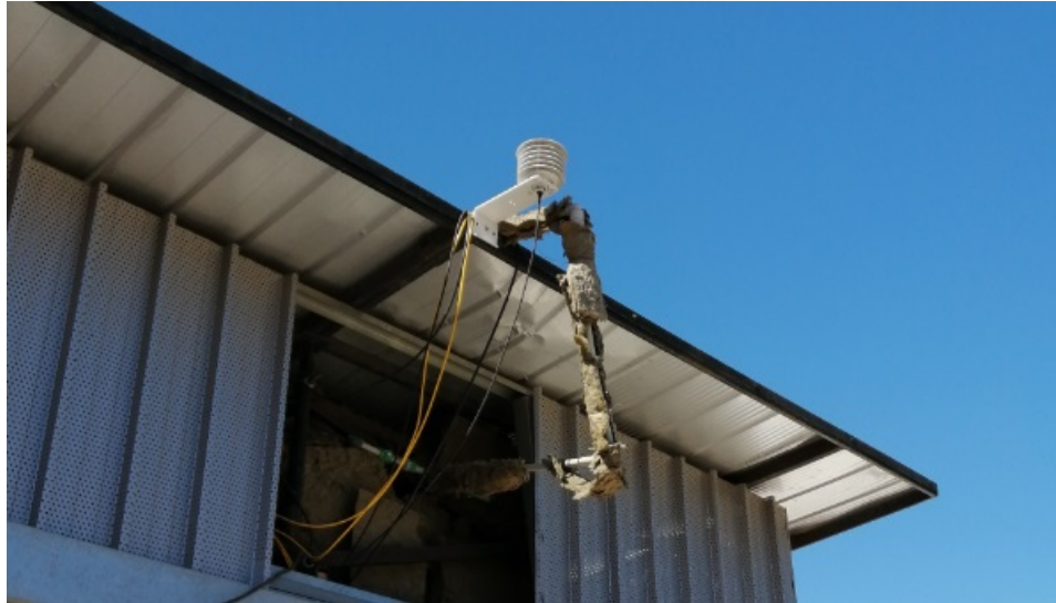
Figura 4.5: Sensor climático instalado en el LER
