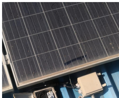
Figura 2.1: Suciedad en panel policristalino del LER.
