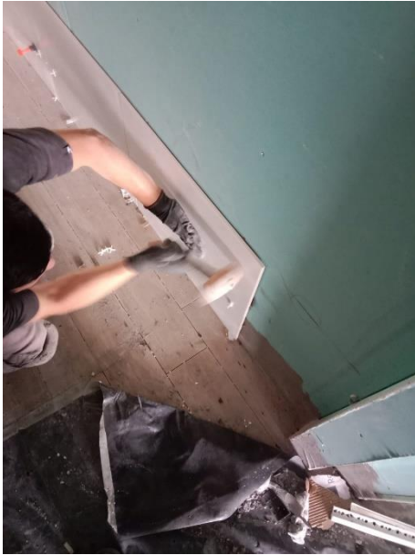
Anexo 3: Instalación de revestimiento de muro interior.
