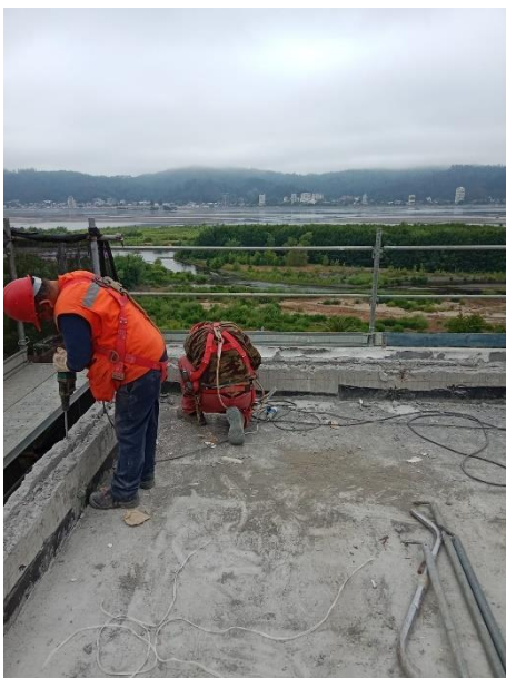
Anexo 2: Perforación de muro de hormigón utilizando el rotomartillo.
