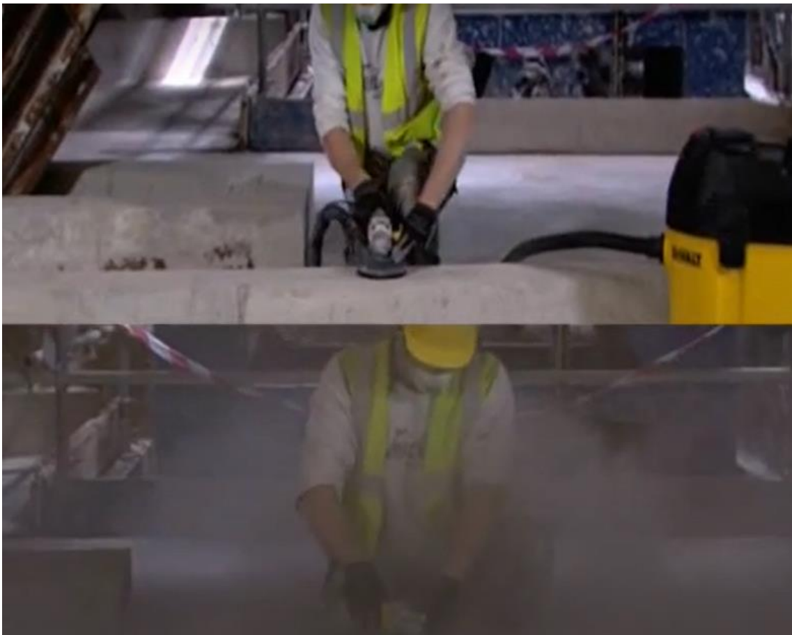
Anexo 8: Guarda extractora de polvo para esmeril angular
