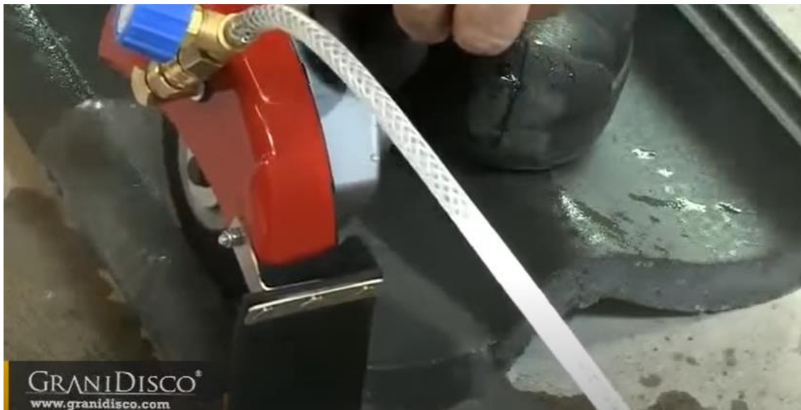
Anexo 5: Uso de esmeril angular con carcasa de agua para trabajo en húmedo
