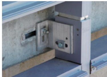
Canal empotrado en canto de losa.
