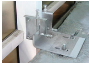
Canal empotrado en cara superior de losa.
