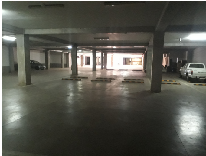
Figura 5.6: Fotografía del espacio de experimentación real, correspondiente al estacionamiento subterráneo
