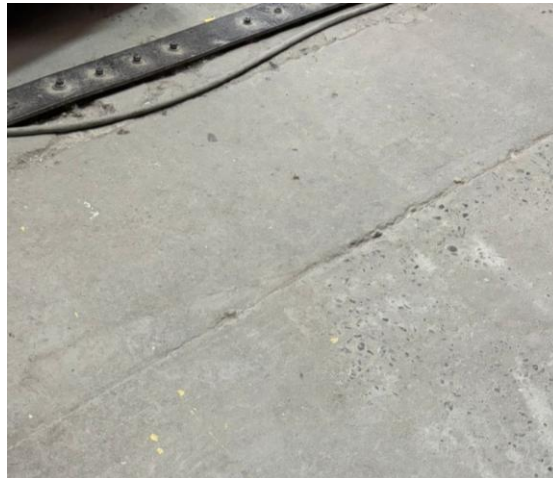
Imagen 7: Piso de hormigón Fuente: Elaboración propia
