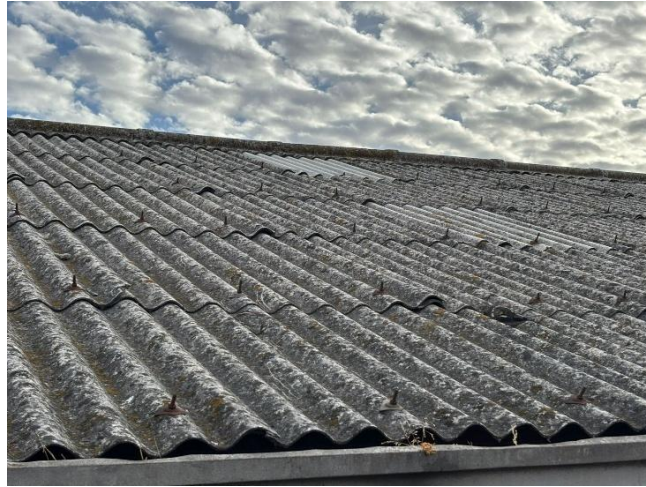
Imagen 6: Cubierta de asbesto Fuente: Elaboración propia
