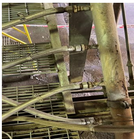
Figura 49. Flexible metálico semirrígido de vapor (Riquelme A., Figura de flexibles metálicos de vapor, 2024)
