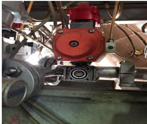
Figura 45. Actuador neumático EA (Riquelme A., Figura de actuador neumático de válvula, 2024)
