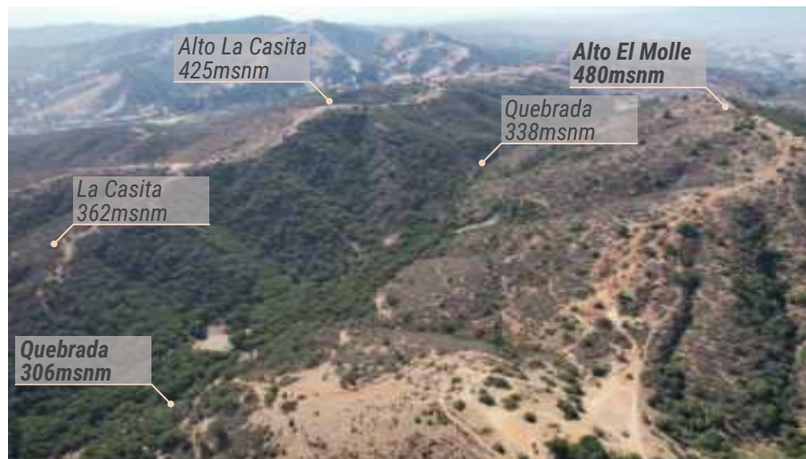
Figura 22: Alturas en el terreno. Fuente: Elaboración propia con fotografía del Drone de Rilarq en 2023.
