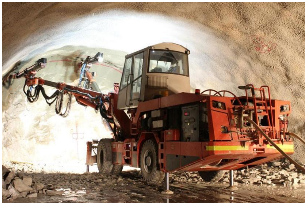
Figura 1.2: Equipo de perforación y tronadura.
