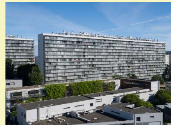
Figura 50: Antes, durante y después de la rehabilitación de viviendas sociales
