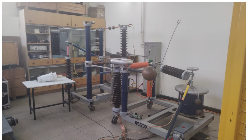
Figura 33: Distribución de equipos en laboratorio de alta tensión para el ensayo de impulso.
