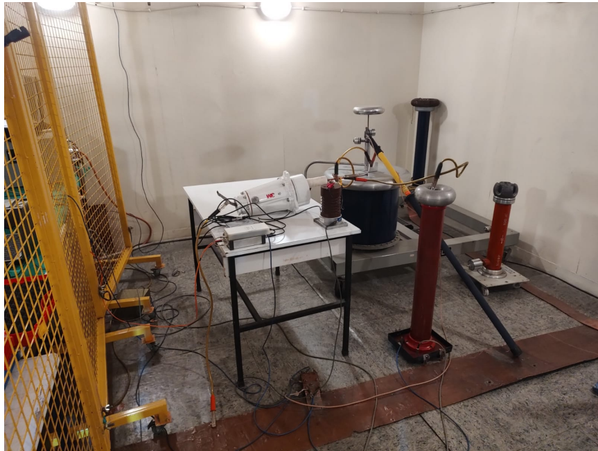
Figura 29: Distribución de equipos en laboratorio de alta tensión para el ensayo de descargas parciales.
