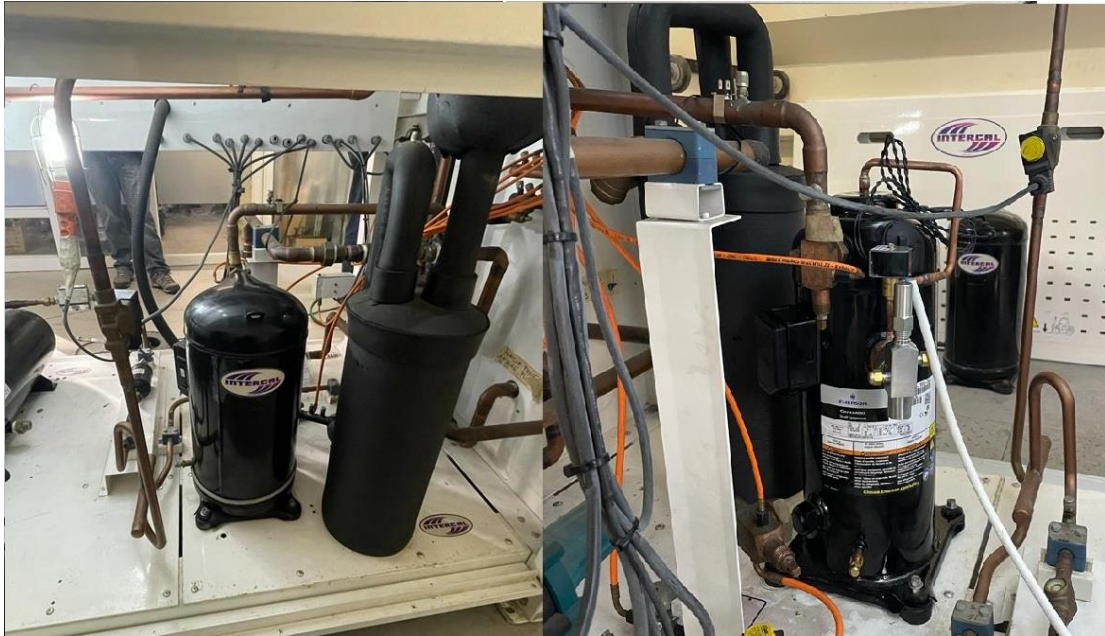
Figura 3.4: Sustitución de compresor convencional por compresor digital.
