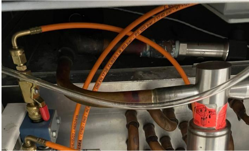
Figura.4: Ubicación del sensor de presión.
