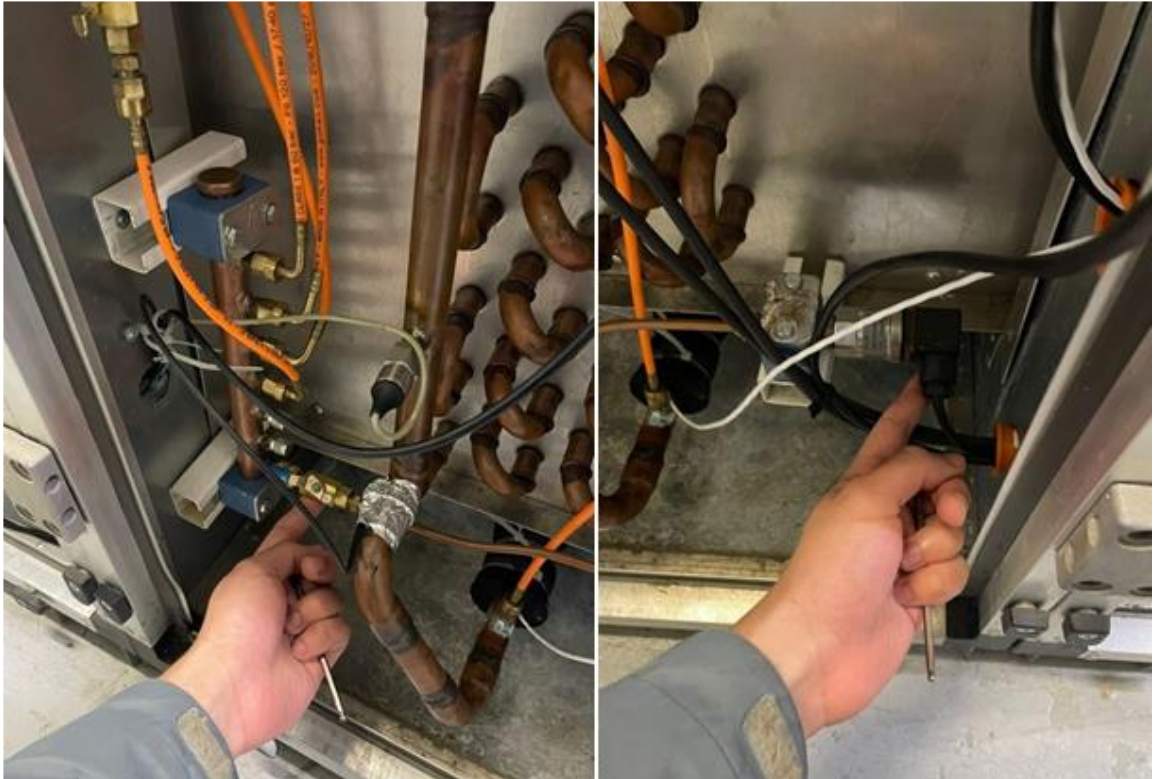
Figura 6: Ubicación manifold y sensor de presión Pr1.
