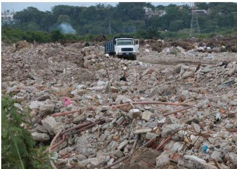
Imagen 5-3: Transporte de RCD a botaderos.
