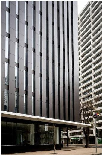
Figura 45. Edificio de oficinas con fachada ventilada Trespá
