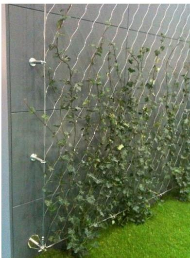
*Figura 6.* Sistema de cables trenzado en forma de rombo.
