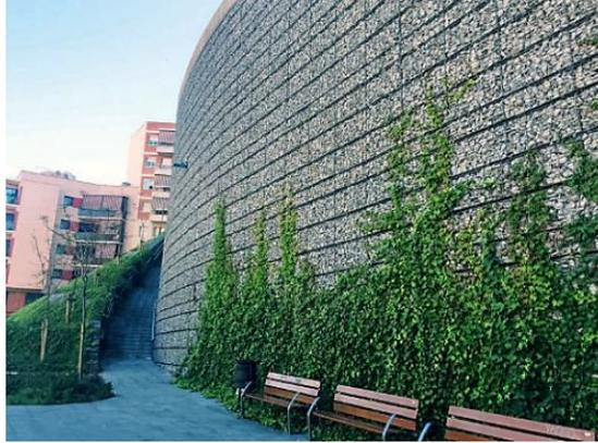
*Figura 20.* Fachada verde con sistema de gaviones metálicos.
