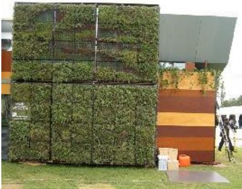
*Figura 15.* Sistema de paneles vegetados en cajas metálicas.
