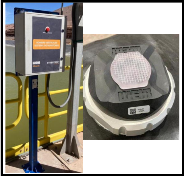
Figura 3-1: Panel y Sensor sistema de monitoreo Synertrex
