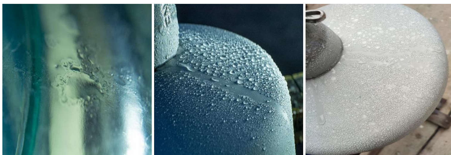
a) Aislador sin recubrimiento.
