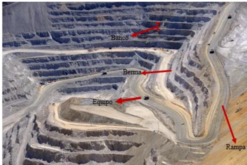
Figura 2. Principales componentes del diseño de una mina de superficie.
