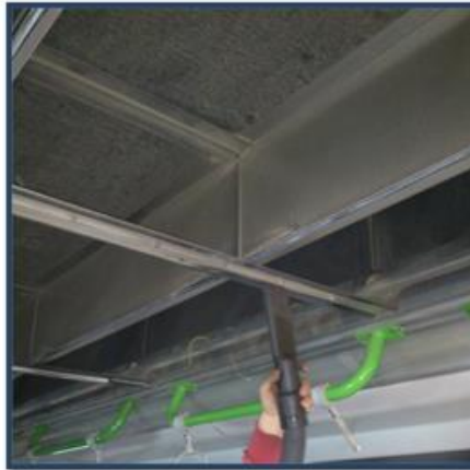
Figuras. (izq. a der.) Aspirado de ducto y de rieles.
