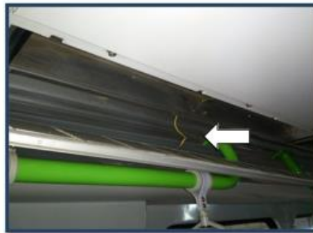
Figuras. (izq. a der.) Desmontaje de rejilla ducto de ventilación y desconexión a masa.
