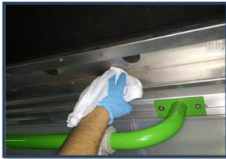
Figuras. (izq. a der.) Limpieza ducto de rejilla y de laterales de ducto central.
