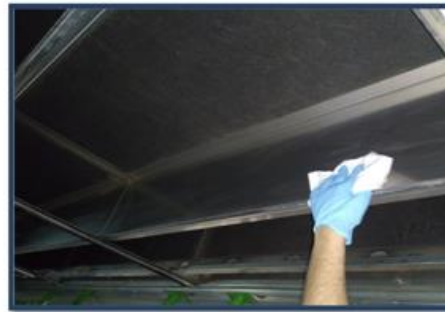
Figuras. (izq. a der.) Limpieza ducto de rejilla y de laterales de ducto central.
