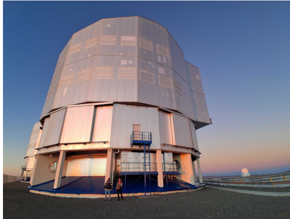
Figura 3: UT 2 visto desde el exterior Fuente: Elaboración propia, tomada el 28/08/2025
